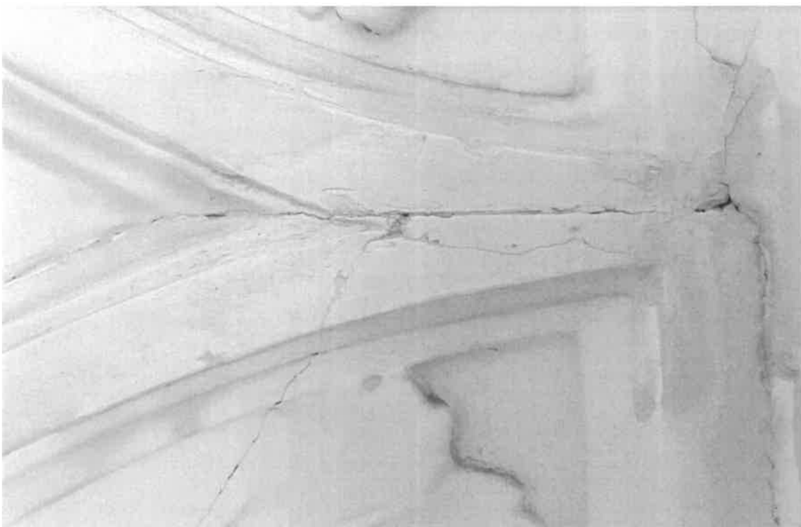
14. Místo předchozí fotografie po zkoušce čištění – praskliny mezi sádrovými díly z forem
