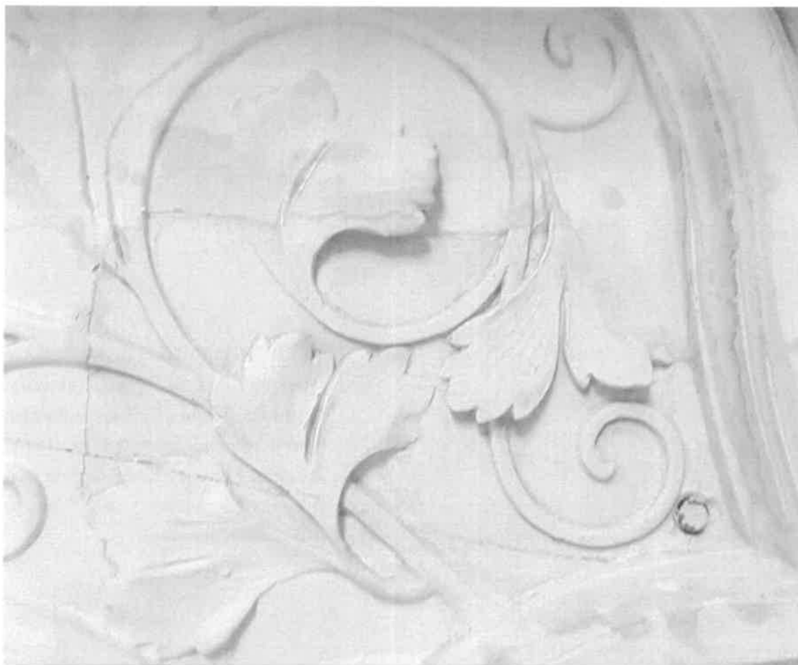
11. Detail dekorativní štukové výzdoby v nice ve vstupním vestibulu – zkouška čištění
