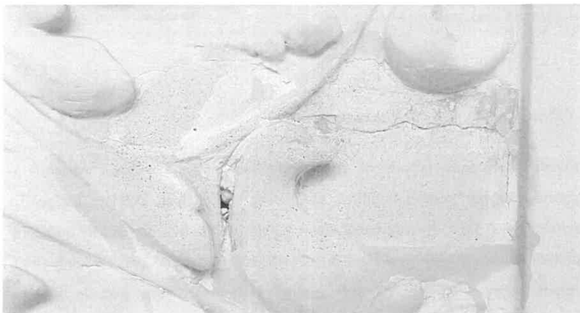
32. Detail zkoušky čištění dekorativního rostlinného štuky s motivem ptáků – pod vrstvou nátěrů se vyskytují praskliny a četné sádrové vysprávkky, které nerespektují původní modelaci z tvrzené sádry
