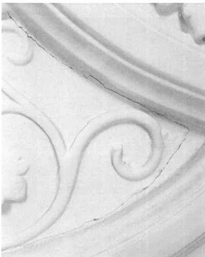
← 9. Detail dekorativní štukové výzdoby v nise ve vstupním vestibulu – vrstvy sekundárních nátěrů zaslepují modelaci, praskliny
