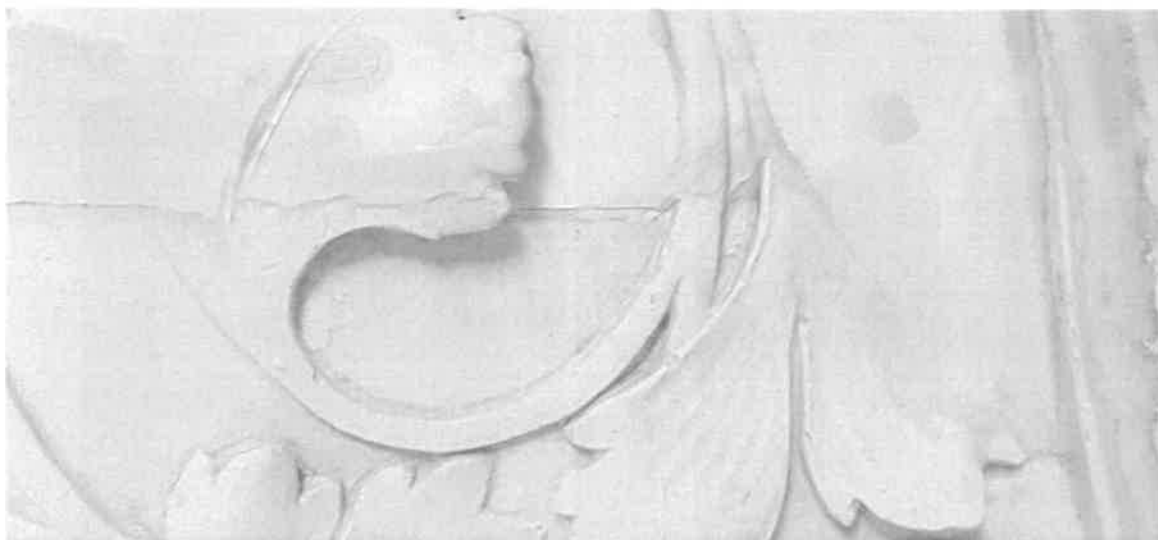
12. Detail dekorativní štukové výzdoby v nice ve vstupním vestibulu – zkouška čištění, zaslepení modelace vrstvou nátěrů
