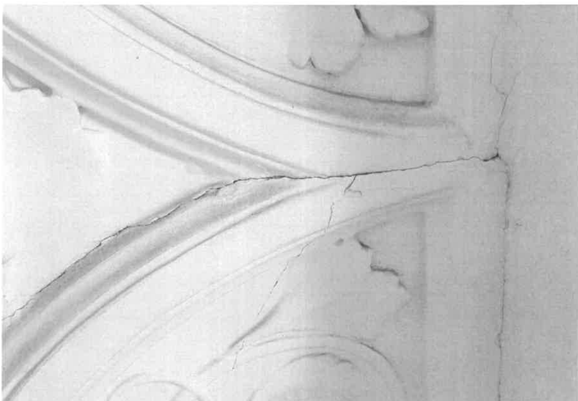
13. Detail dekorativní štukové výzdoby (nika, vstupní vestibul) – před provedenou zkouškou čištění, praskliny, vrstvy nátěrů, které zaslepují modelaci
