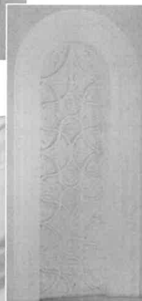
↑ 7. a ↓ 8. Detail dekorativní štukové výzdoby v nice orámované širokou štukaturou v podobě odstupňovaných oblouků: poškození
