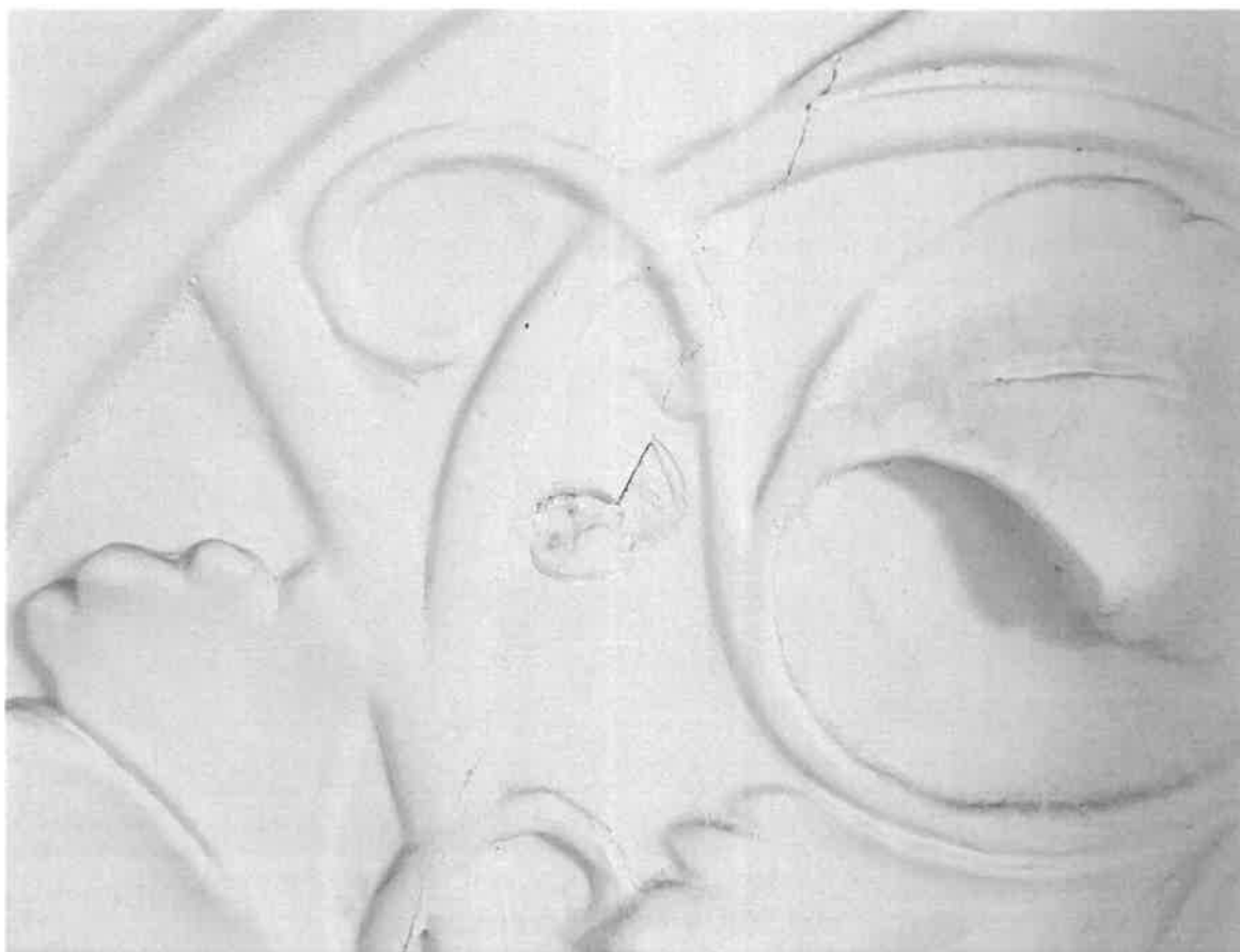
15. Detail dekorativní štukové výzdoby (nika, vstupní vestibul) – před provedenou zkouškou čištění, praskliny, vrstvy nátěrů, které zaslepují modelaci, znečištění
