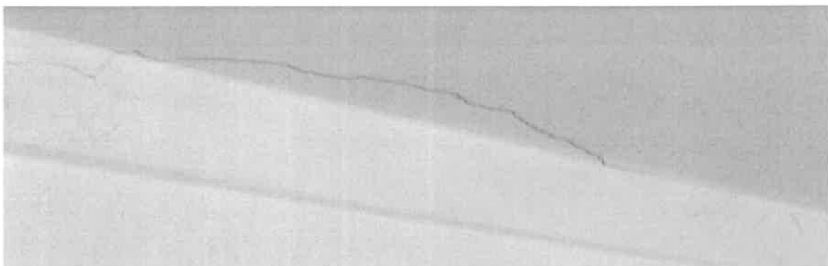
↑21. a ↓ 22. Detail štukové římsy, výzdoba vstupního vestibulu – vrstvy sekundárních nátěrů zaslepují modelaci, praskliny a trhliny
