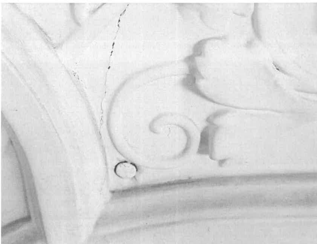
↓ 10. Detail dekorativní štukové výzdoby v nise ve vstupním vestibulu – vrstvy sekundárních nátěrů zaslepují modelaci, praskliny, korodující kovový hřeb, kterým jsou jednotlivé sádrové díly reliéfu přikotveny
