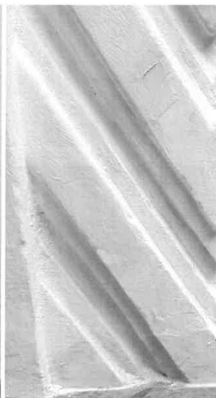
25. Místo předchozí fotografie po zkoušce čištění – zaslepení profilace vrstvou nátěrů
